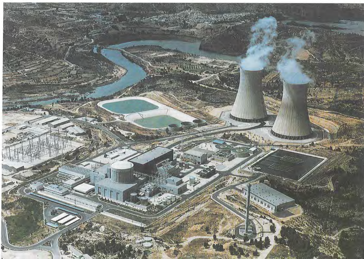
Vista general de la central nuclear de Cofrentes
