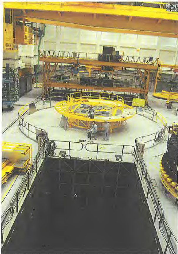
Edificio de combustible de la central nuclear de Santa María de Garoña
